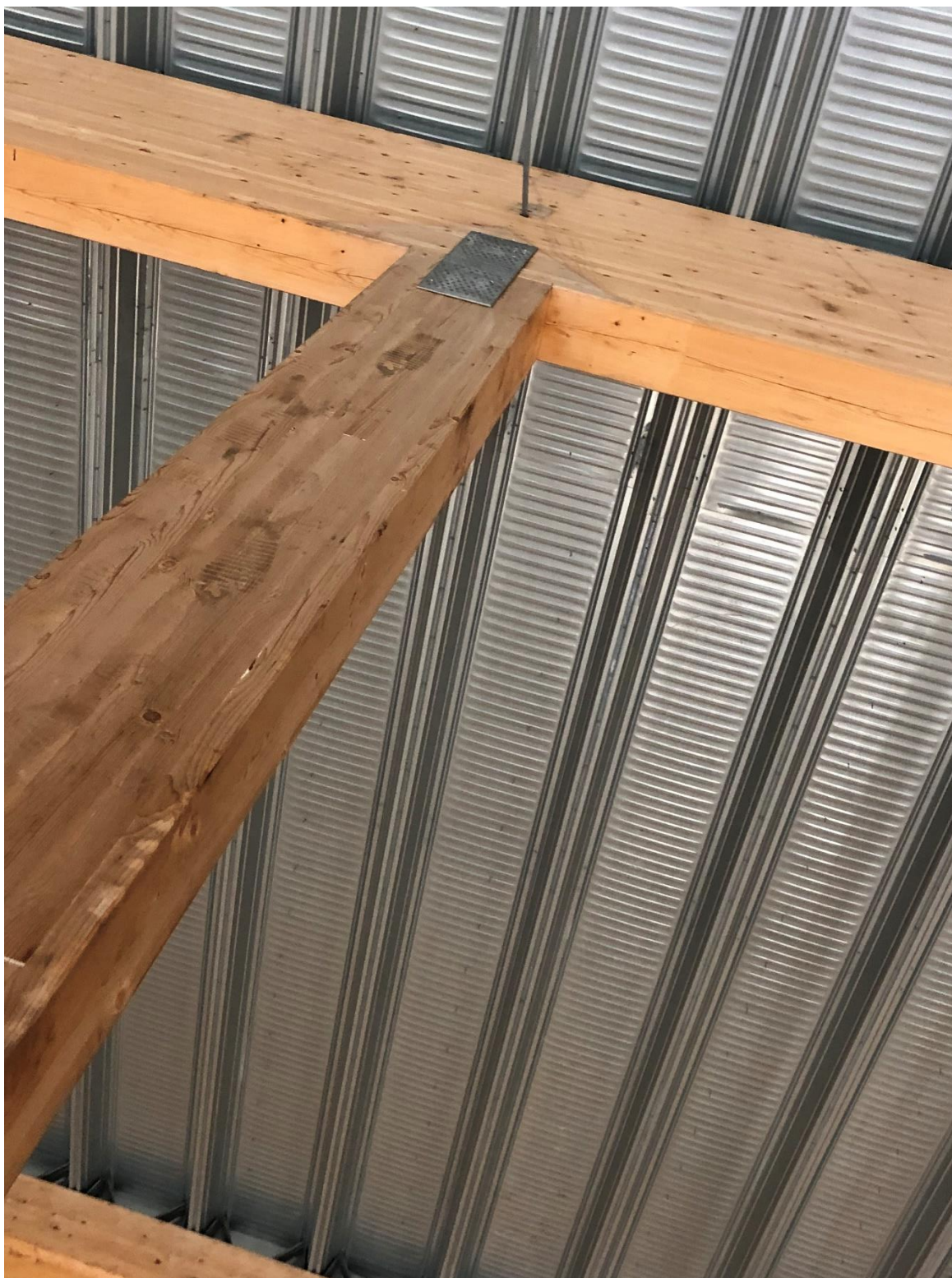
Bild 1. Anslutning mellan stötta och balk
